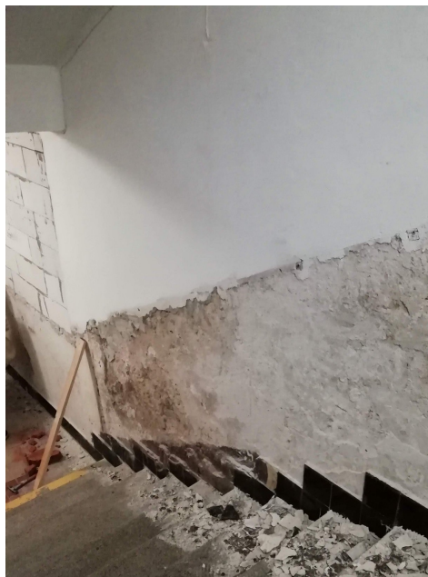
Práce na omítkách
